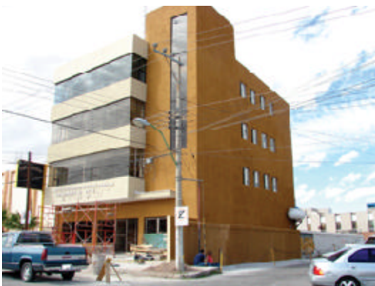
Trabajos de remodelación del edificio sede del ICHITAIP.
